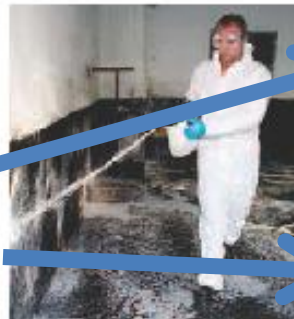
PSA beim Verschäumen eines bestimmten Desinfektionsmittels mit Desinfektionsspritze
